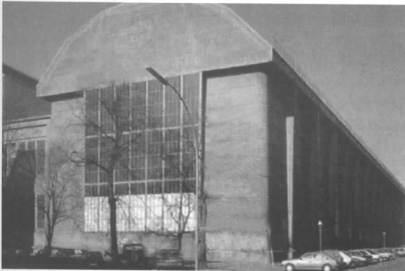
Nave de turbinas de AEG (1908-1909) en Berlín.
