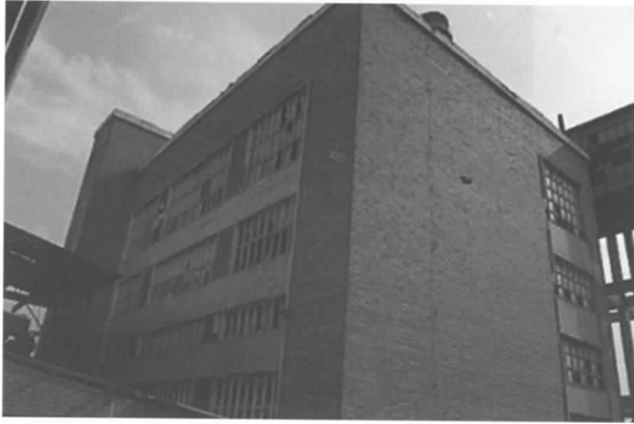
Térmica Málaga. Edificio de calderas (R. Marín).
