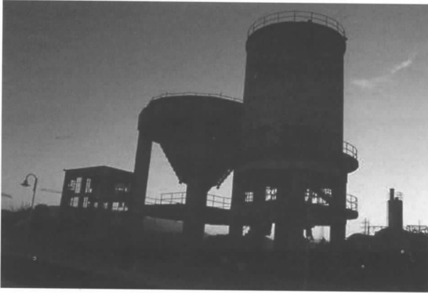
Conjunto de depósitos de las insalaciones (R. Marín).
