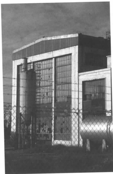
Alzado principal de las naves de turbinas (Foto R. Marín).
