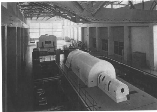
Interior de la nave de turbinas poco después de la inauguración (Folleto de la Compañía).
